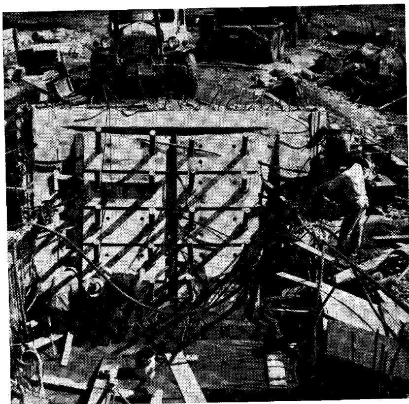
Fig. 12—Rock Anchorages
